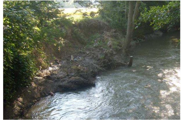
B2) Déstabilisation d'une partie de berge sur le T002 influencé par le remous de l'ouvrage de la Verte Vallée (situation vannes fermées et vannes ouvertes)
